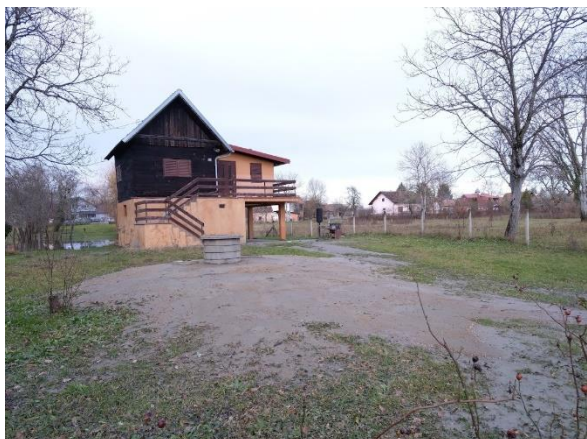
Slika 14 Izbacivanje pijeska kroz bunar u Letovaniću. Likvefirani sloj pijeska izlazi na površinu pa su brojni bunari ispunjeni pijeskom.
