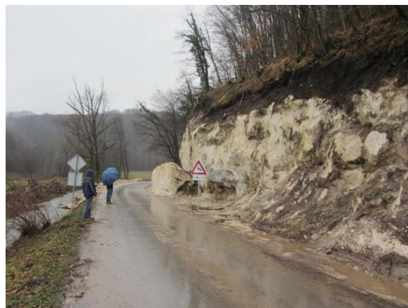
Slika. 4 Odron na cesti prema mjestu Pecki nastao 29.12.2020.; registrirano 3.1.2021.
