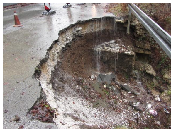
Slika 2 Plitko klizište na cesti kod naselja Donji Hruševac registrirano 4.1.2021.
